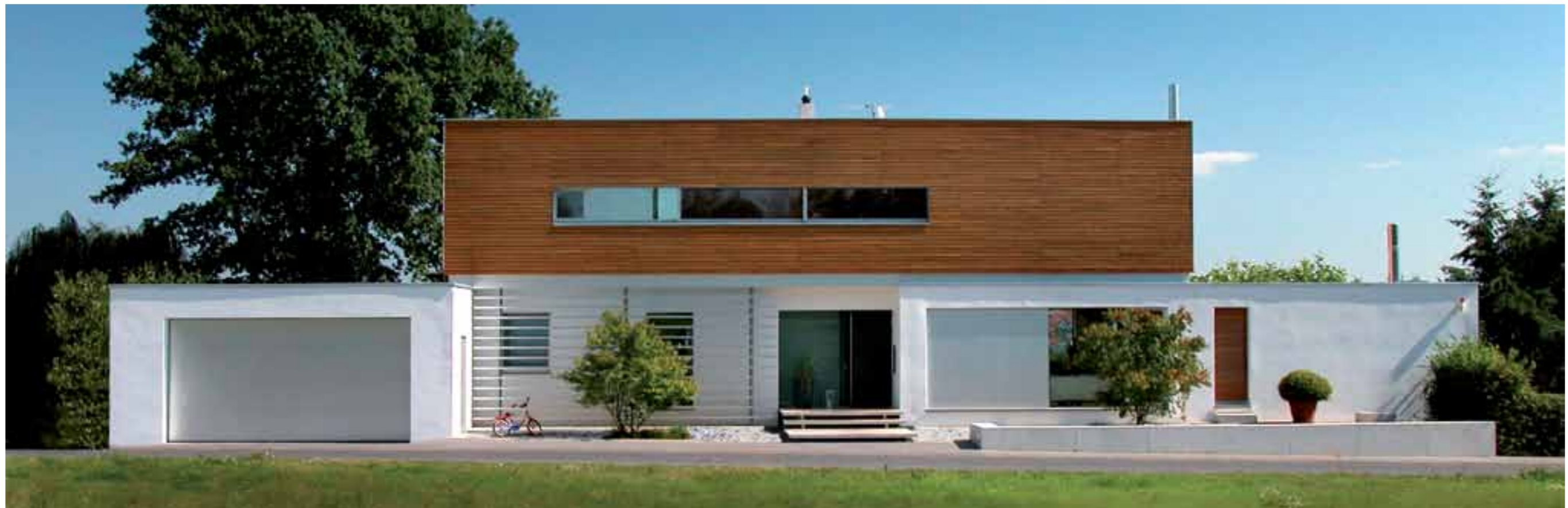
Hybrid: Aufstockung, Modernisierung und Anbauten bei einem Wohnhaus aus den 1960er-Jahren. Architekt: Reith + Wehner
