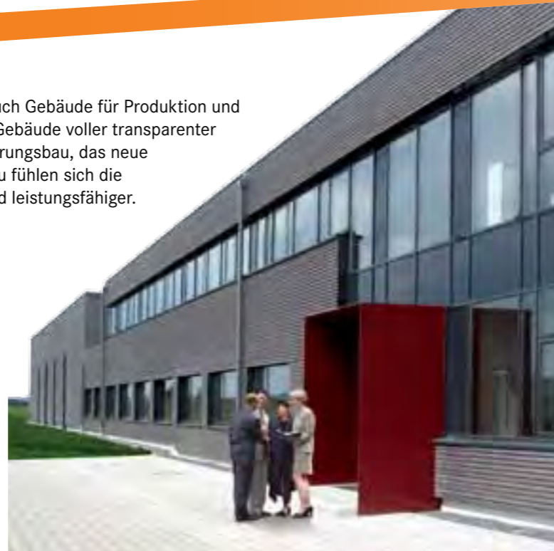
Energieeffizientes Bürogebäude mit Produktionshalle, Architekt: Rohrbach und Schmees
