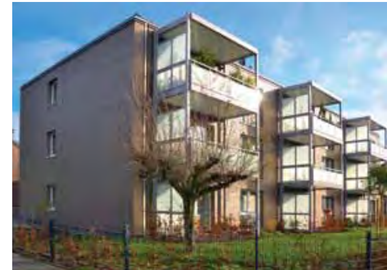
Innovative Fassadenmodernisierung mit vorgesetzten Holzbauelementen. Architekt: Probst und Wilke
