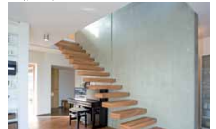
Die Treppenstufen „schweben“ – sie wurden an der Wand fixiert
