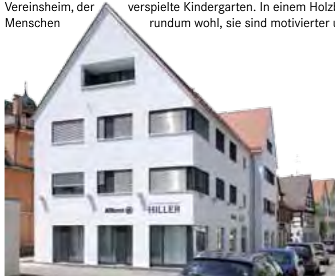
Passivhaus-Verwaltungsgebäude: drei Geschosse plus Dachgeschoss, ca. 1.500 m 2 Nutzfläche
